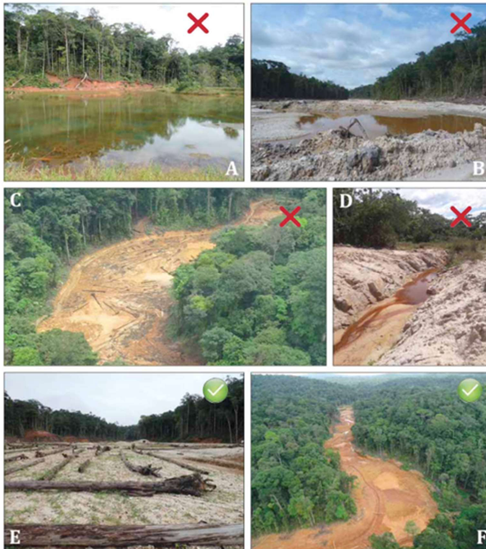
Figure 3. (A, B) Exemples de barranques peu ou mal rebouchées. (C) Les barranques sont correctement rebouchées mais la crique est maintenue dans le canal de dérivation. (D) Un canal de dérivation non rebouché capte une partie des écoulements. (E) Barranque correctement rebouchée. (F) Barranque et canal de dérivation correctement rebouchés. Le lit reconstruit présente une sinuosité cohérente.
