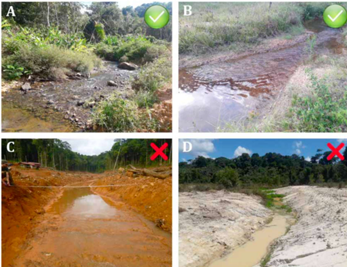
Figure 6. Exemples de radiers correctement réalisés sur des criques réhabilitées. Ils permettent une bonne diversification des écoulements et stabilisent le lit de la crique (A et B). Les photos C et D montrent des secteurs qui devraient nécessairement présenter des radiers mais qui n'en accueillent pas. L'absence de matelas alluvial accroît fortement l'érosion de la section et le risque d'incision du lit de la crique.
